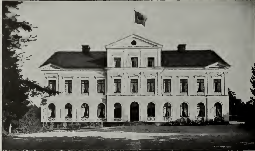
Norra fasaden, gårdssidan.
